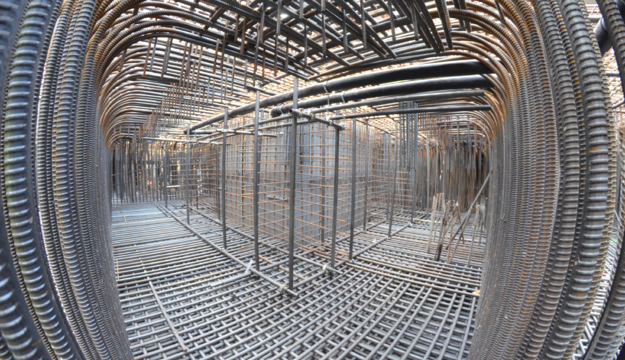
Tra gli strati di armatura Foto: © Lupp
